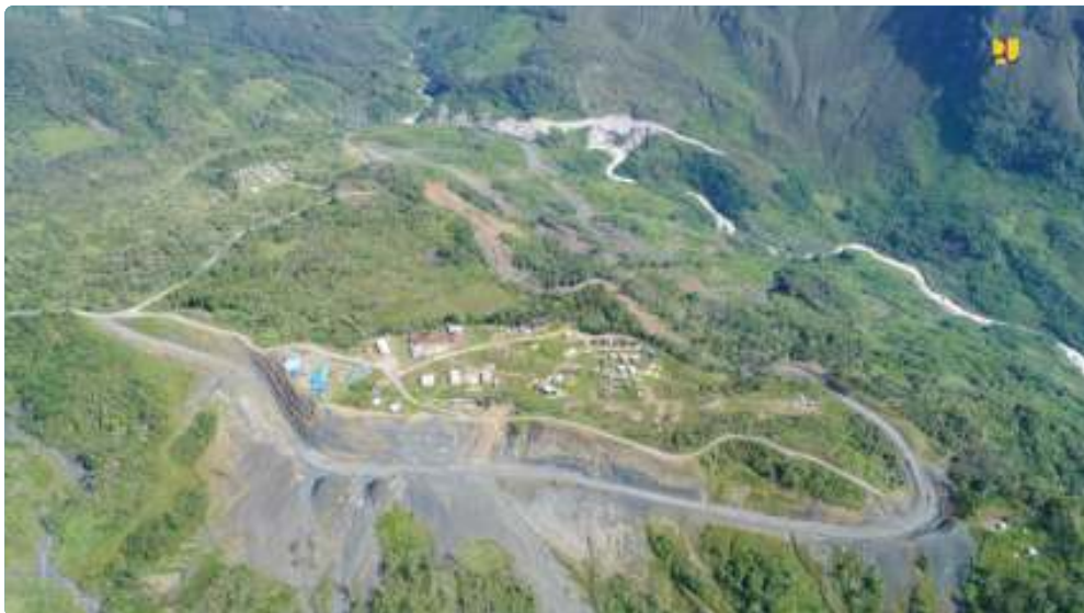
Gambar 1.7 Proyek Jalan Trans-Papua, Bagian dari Pemerataan Pembangunan
