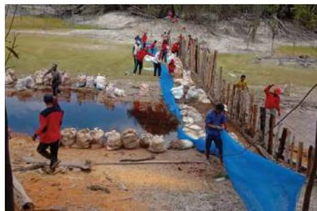
**Gambar 4.59** Membuat embung untuk cadangan air antisipasi kebakaran hutan.
